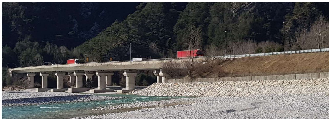
Fig. 1 - Il ponte autostradale sul rio Glagnò con la protezione spondale in pietrame recentemente realizzata sul fiume Fella
