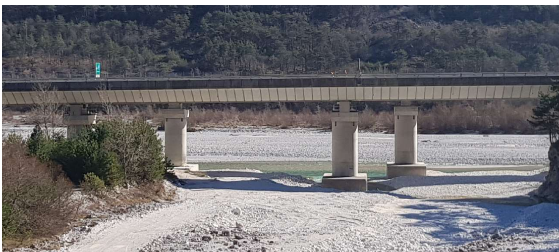
Fig. 4 - Le quattro pile di sostegno del viadotto A 23 in corrispondenza della confluenza del rio Glagnò
