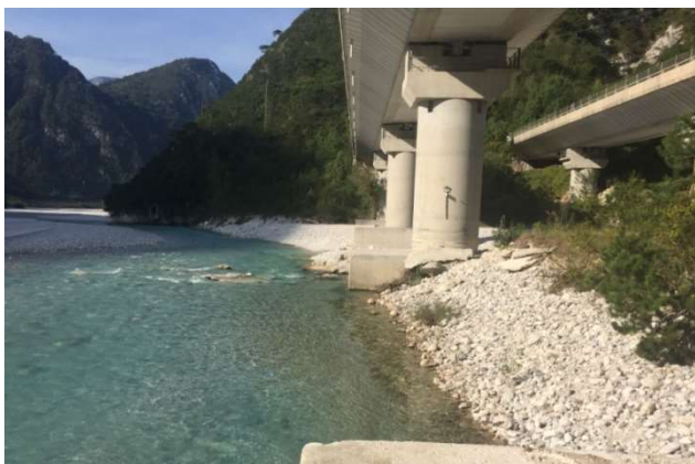
Fig. 2 - Vista della pila n.4 dx con fenomeni di erosione alla base del plinto
